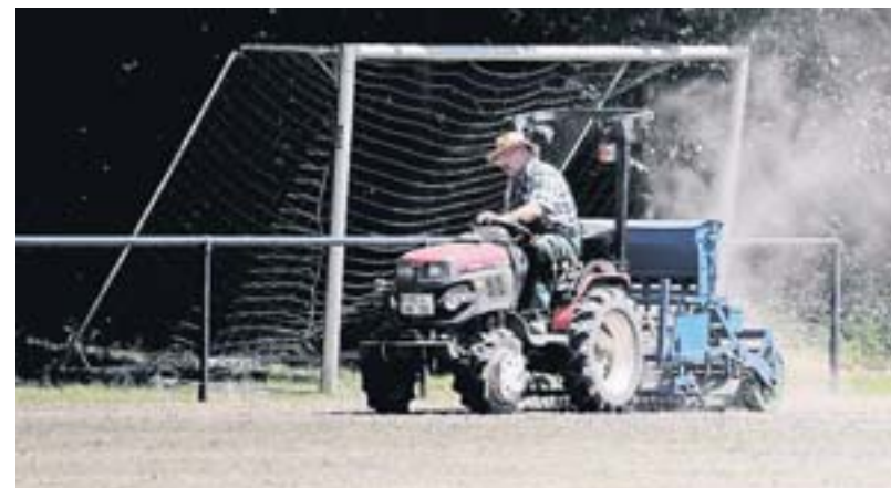
Da wo noch eine Woche lang Fußball gespielt werden sollte, wurde schon der alte Rasen komplett abgetragen und der neue Rasen eingesät.
